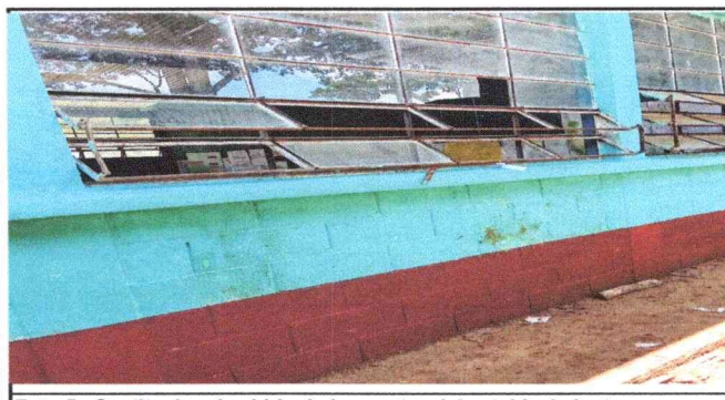
Foto 5: Sustitucion de vidrio de las ventas del establecimiento
