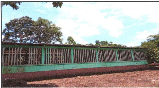
Foto 3: Sustitucion de balcon del establecimiento por balcones de metal
